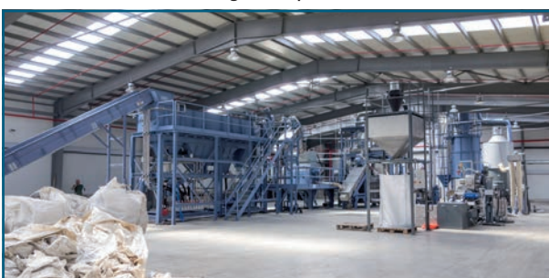
Fig. 3 : Installation de lavage pour films agricoles en Bulgarie
