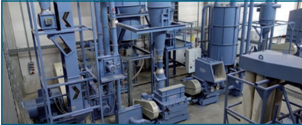
Fig. 7 : Centre d'essais à sec
