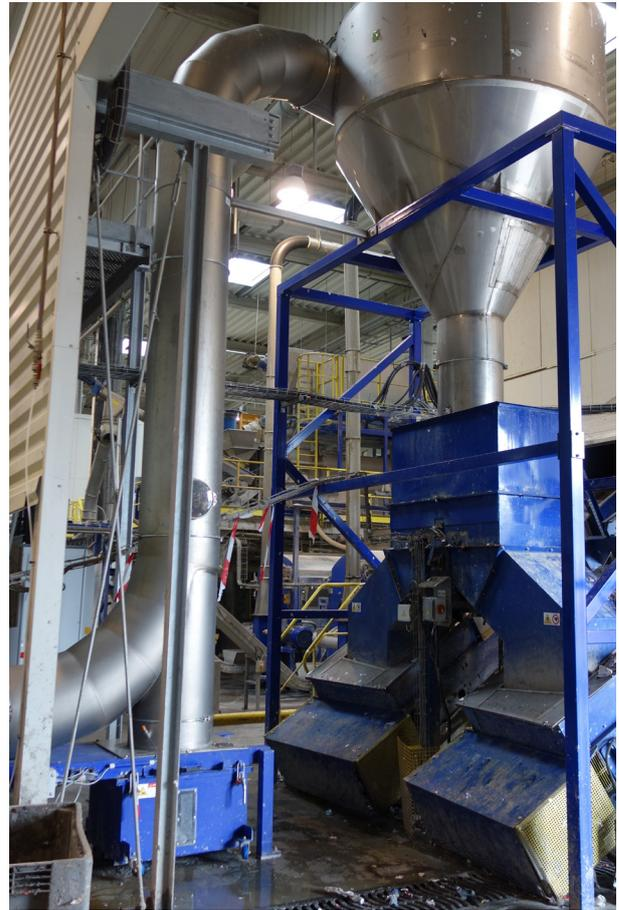
**Abb.3:** Steigrohr mit Austragsschacht und Zyklon für den Gutauswurf in einen Ballistikseparator.
