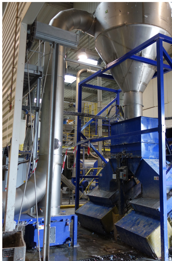
Fig. 3: Tuyau ascendant doté d'une gaine de décharge et cyclone pour la décharge de la matière à valoriser dans un séparateur balistique.
