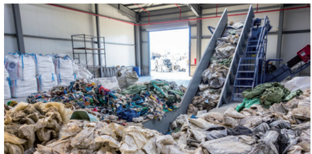
Fig. 2: Convoyeur placé sous le niveau du sol pour l'alimentation des matières en vrac et séparées
