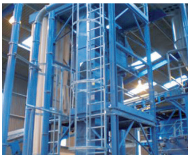
Fig. 2: Clasificador por gravedad con plataforma de mantenimiento
