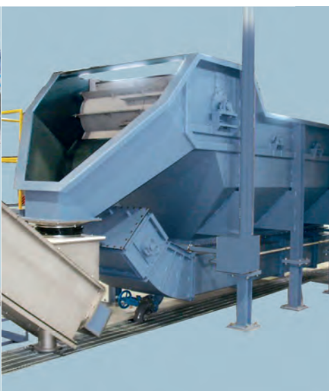
Флотационный резервуар со скребковым конвейером
