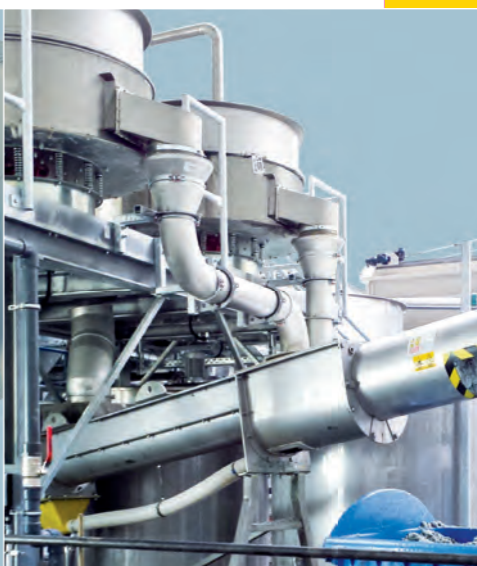
Установка подготовки воды
