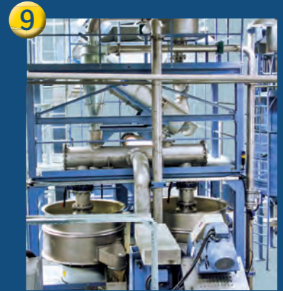
Étape de séparation à haut rendement avec hydrocyclone
