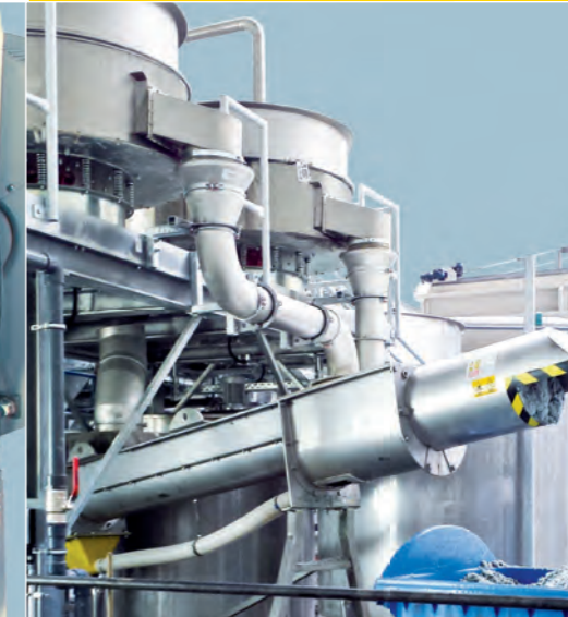
Unité de traitement des eaux usées
