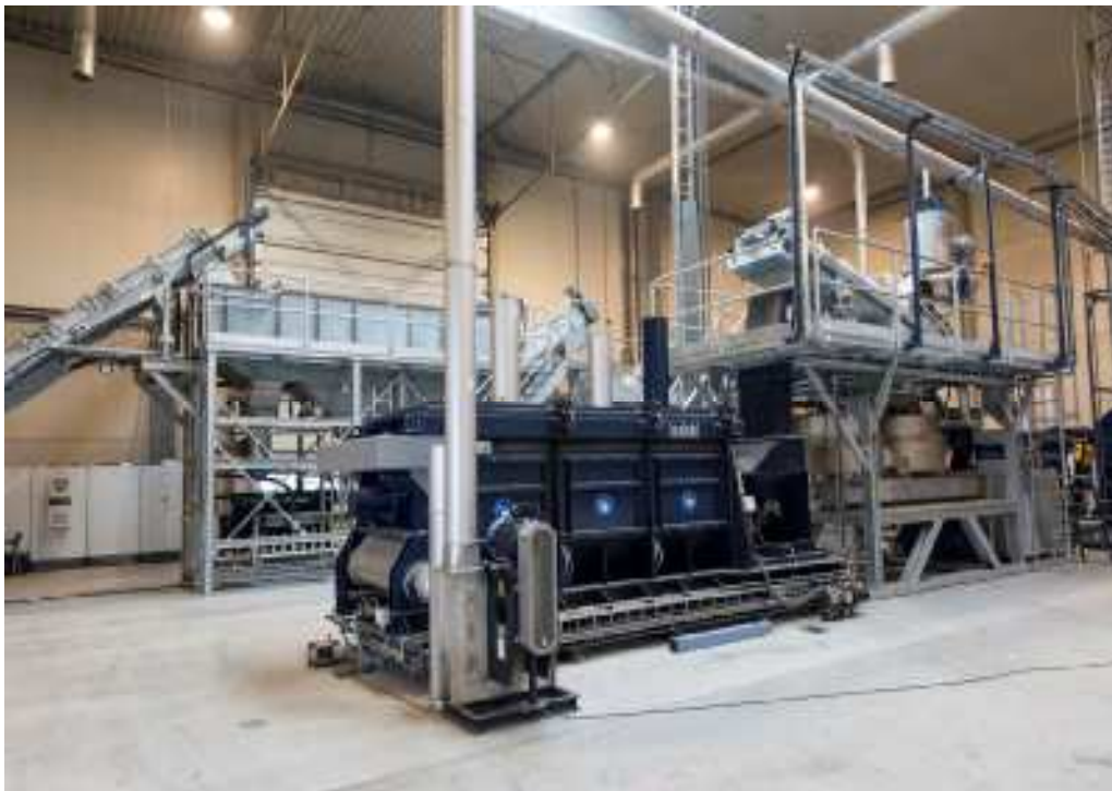
Foto 3) Hidrociclón + Instalación de secado, en la parte posterior Instalación de prelavado
